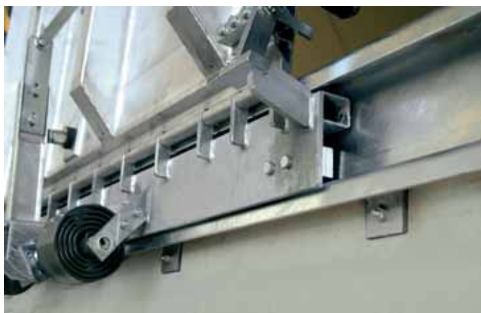
Jeklena plošča 80 x 80 x 10, pritrjena na spodnji strani tračnice ali nepremičnega nosilnega mostu.
