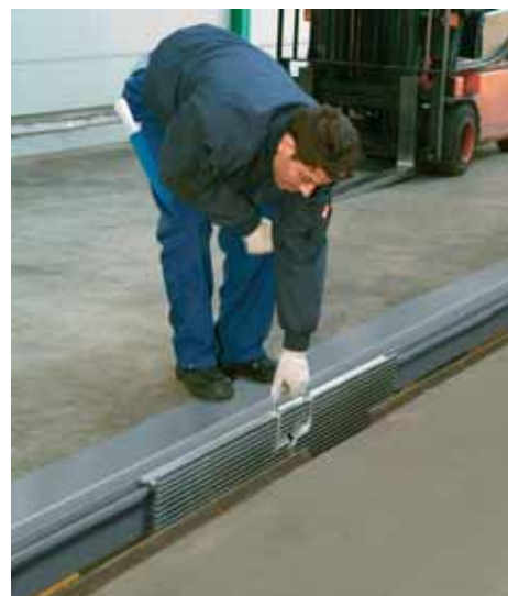
Dviganje nosilnega mostu iz vodljive tirnice.
